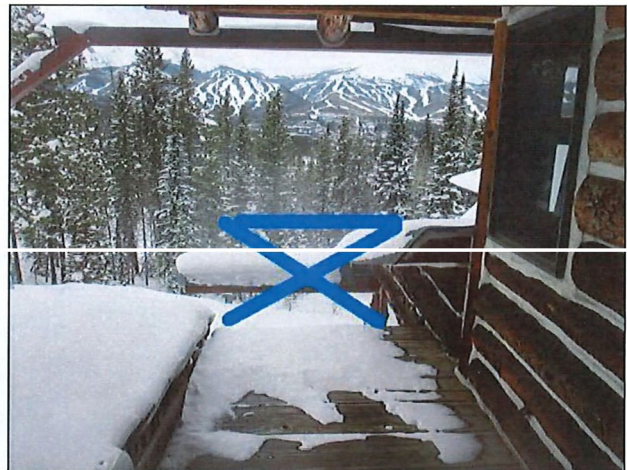
1.4 Install guardrail.
